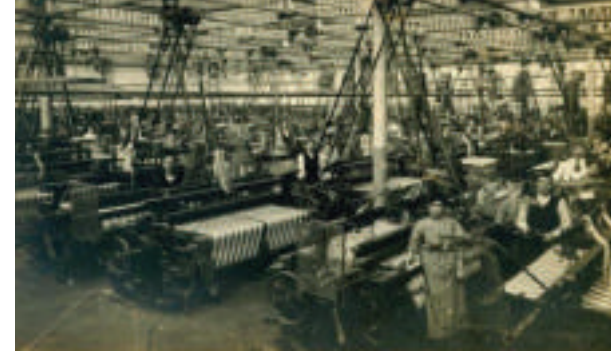
Salle des métiers dans la partie détruite.
