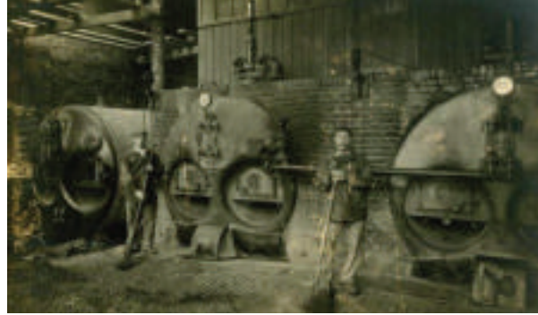
Chaufferie à charbons.
